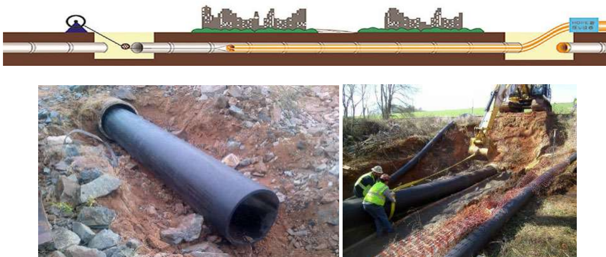
Figura 4. Metoda de reabilitare „Slip lining” [2]
