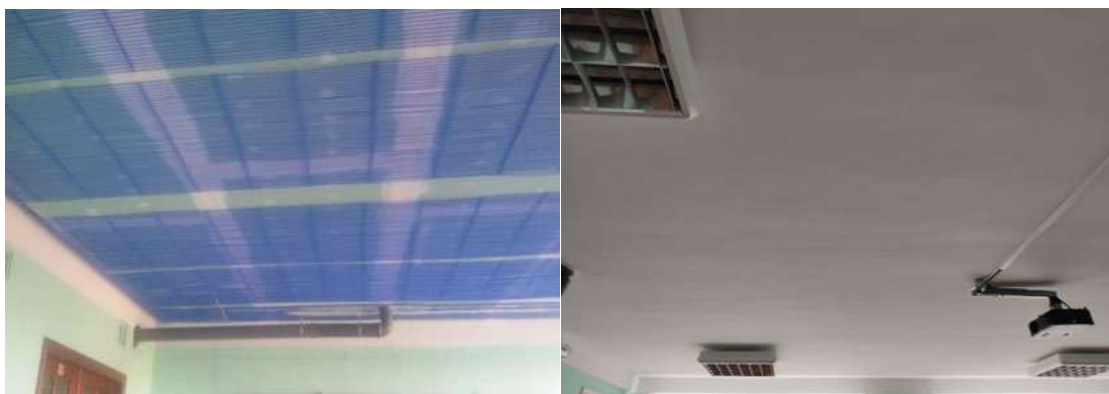
Figura 2. Vedere a tavanului cu covorașele cu tuburi capilare până și după acoperirea cu tencuială și stratul de vopsea
