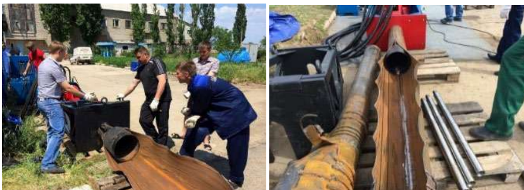
Figura 3. Principiul de spargere a conductei prin metoda de reabilitare „Pipe bursting”
