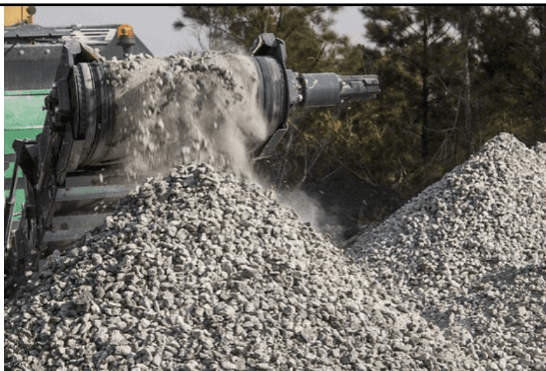
Figura 2. Concasarea betonului, ulterior, pentru fabricarea betonului reciclat
