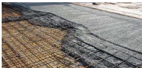
Figura 7. Beton armat în procesul punerii în operă [20]
