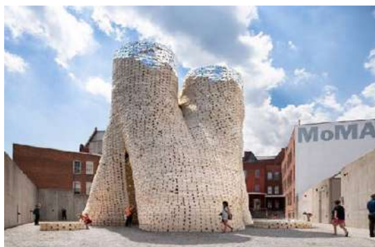
Figura 4. Obiectiv executat din cărămizi din miceliu [17]
