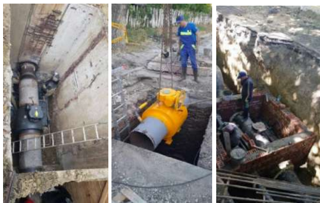
Figura 9. Armături de închidere sudabile fără flanșe
