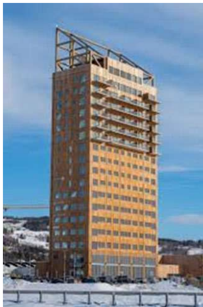
Figura 2. Clădirea multifuncțională Mjostarnet, cu 18 nivele, executată din lemn [33]
